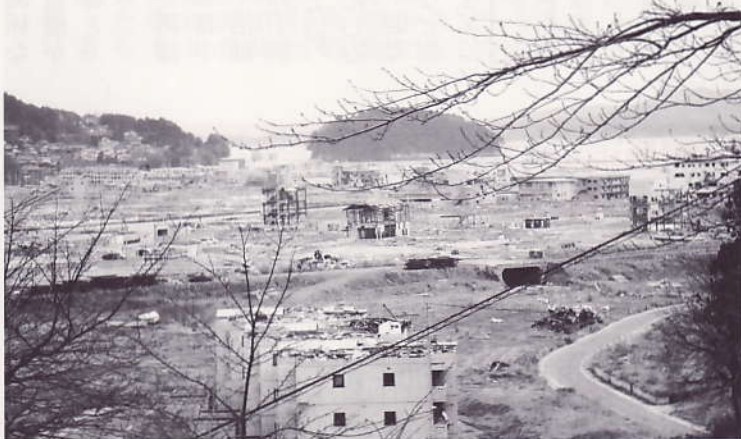
志津川高校前の被災写真
