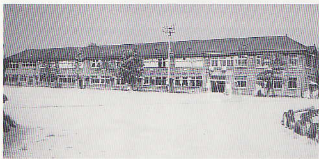
古川第一小学校 南北校舎
